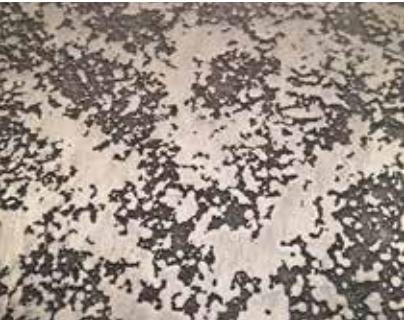
Bronzo corrosivo Corroded bronze
